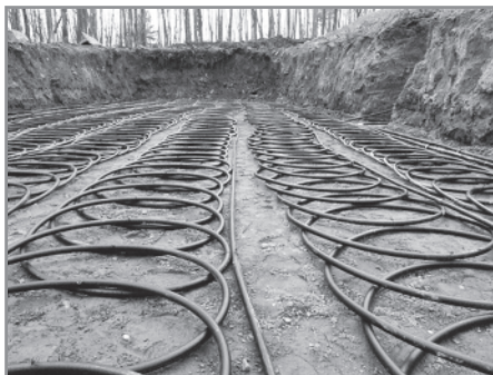
Figura 8a. Sonde circuito chiuso Slinky.
