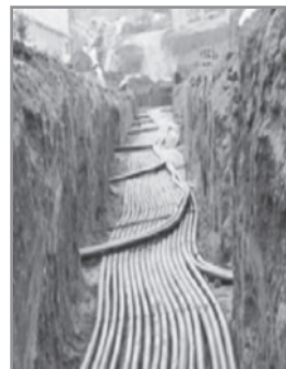
Figura 8c. Sonde collettore in orizzontale.
