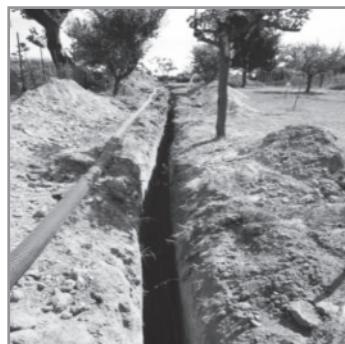
Figura 10a. Tipologia di posa di sonde.
