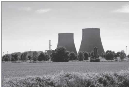
La centrale elettronucleare Trino 2 doveva essere la seconda centrale elettronucleare del comune di Trino (più precisamente nella frazione di Leri Cavour, alcuni chilometri a nord-ovest della centrale elettronucleare Enrico Fermi), la prima in Italia basata sull'allora nascente "Progetto Uni-ficato Nucleare" e avente due reattori PWR da 950 MW di potenza elettrica netta ciascuno a uranio a medio arricchimento.
