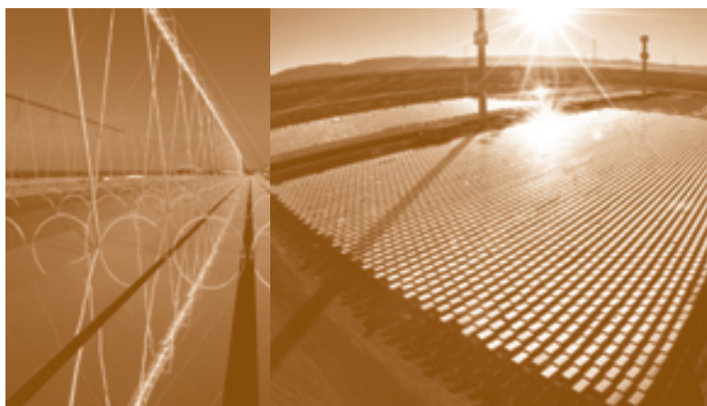
A sinistra l'impianto di Kimberlina dell'Ausra (2008). A destra una vista della Sierra SunTower facility della eSolar (2009).
