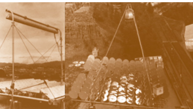
I pionieristici impianti solari a concentrazione progettati, costruiti e sperimentati da Giovanni Francia. A sinistra il primo impianto al mondo lineare Fresnel sul tetto dell'Università di Marsiglia (anno 1963). A destra il primo impianto al mondo puntuale Fresnel o a torre costruito presso la stazione solare di S. Ilario (Genova) (anno 1965)
