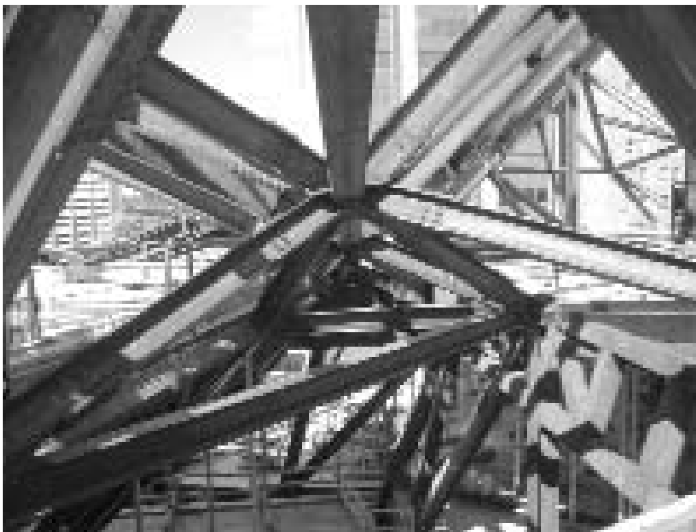
Particolare dell'assemblaggio delle travi del Crystal Renaissance ROM
