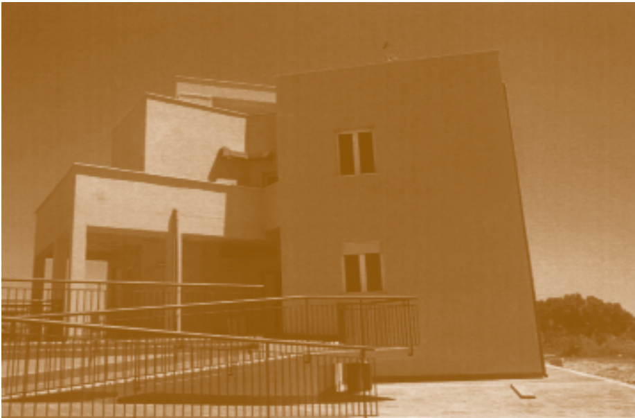
Fig. 4 - La "Casa Intelligente" presso il CR-Casaccia dell'ENEA
